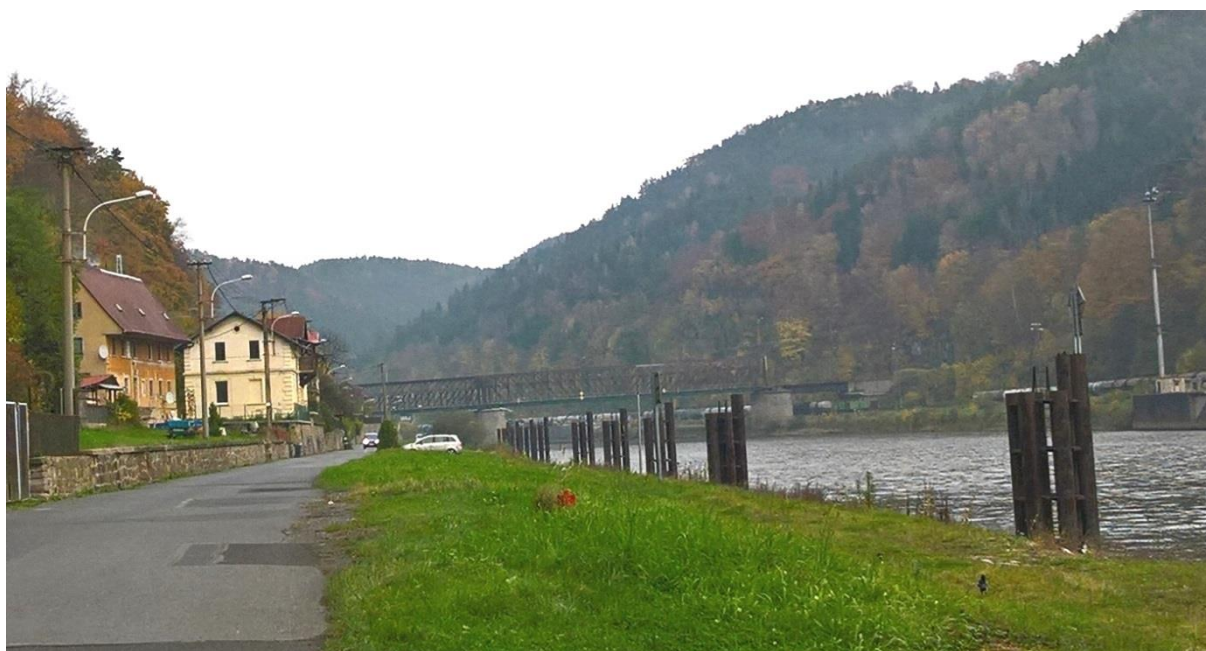
Obr. 5 – dnešní ocelový most přes Labe, který bude nahrazen novým, s průběžným šterkovým ložem a tedy výrazně tišším.
